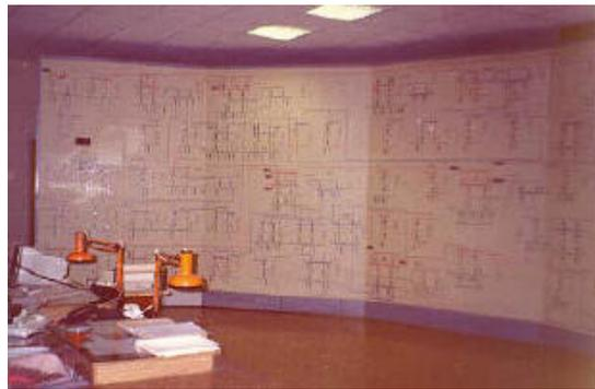
Щит диспетчерский универсальный ЩДУ 1 служит для размещения на нем мнемонических схем энергетических и других промышленных сетей, находящихся в оперативном ведении диспетчера. Щит предназначен для использования совместно с аппаратурой телемеханики и связи в установках автоматизированных систем диспетчерского управления (АСДУ). Щит ориентирован для работы в комплекте с различными системами телемеханики.
